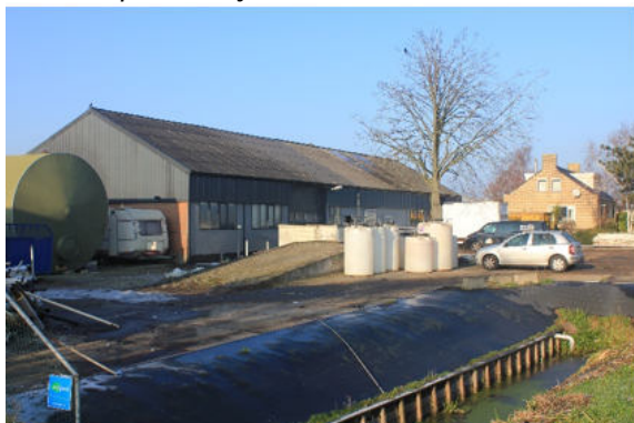
De te slopen bedrijfsloods.
