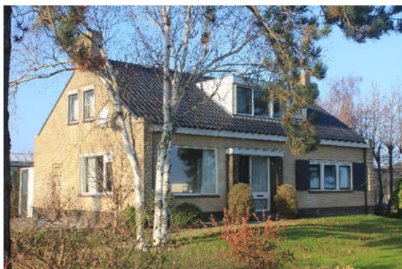
De naastgelegen woning Middelweg 1b.
