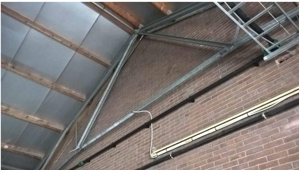
Figuur 6: Binnenzijde zuidelijk deel van de loods
