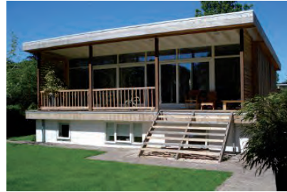
plat dak met wateropvang
