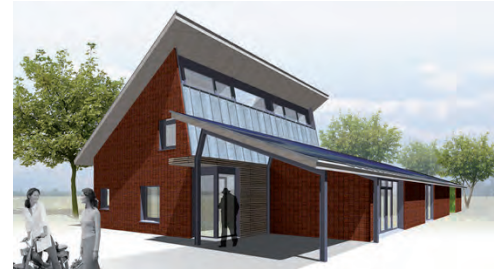
lessenaarsdak met zonnepanelen
