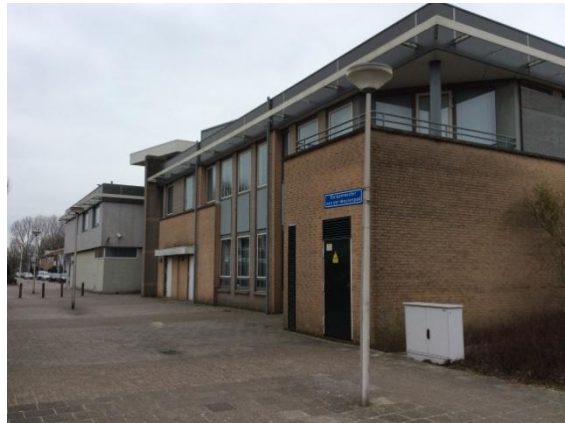
Foto 2: Noordwestelijke deel van de locatie. De foto is gemaakt richting het oosten.
